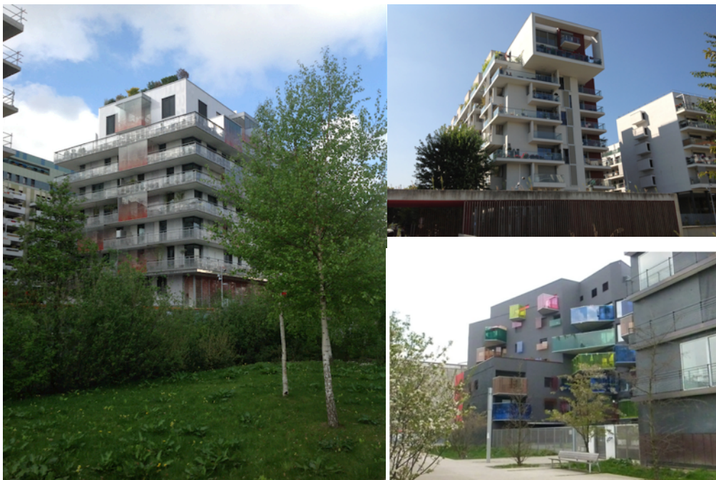
Figure 41 : photos de logements dans le quartier du Trapèze
